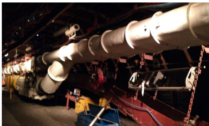
Système d'aération des galeries (Photo JL Muller)
